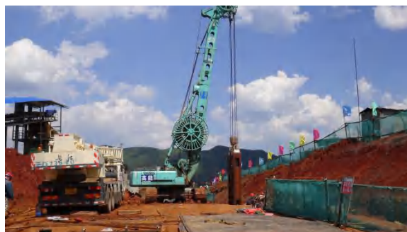
柔性垂直生态屏障系统安装实物图
